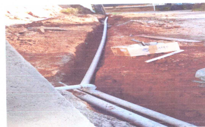
INSTALAÇÃO HIDROSANITÁRIA
