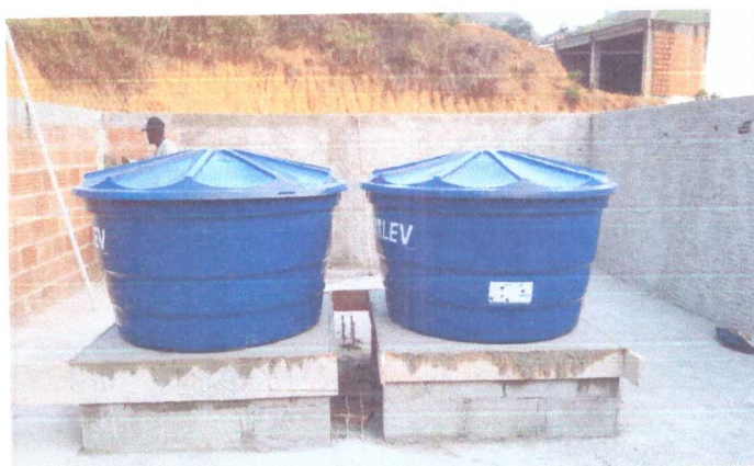
FORNECIMENTO E INST. CAIXA D'ÁGUA
